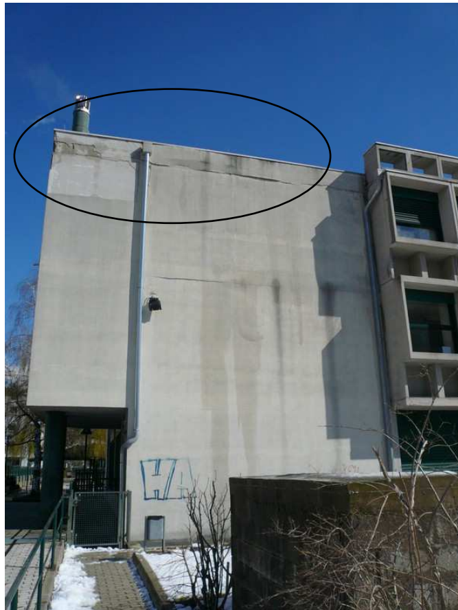
(Einsickerndes Wasser an der Fassade mit Putzablösung)
