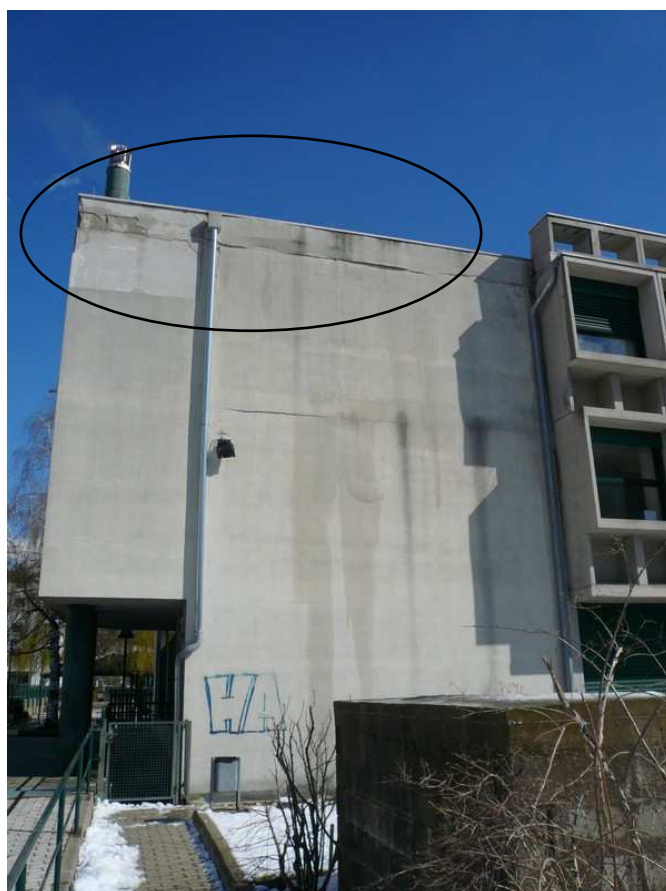
(Infiltrazioni in facciata con distacco intonaco)
