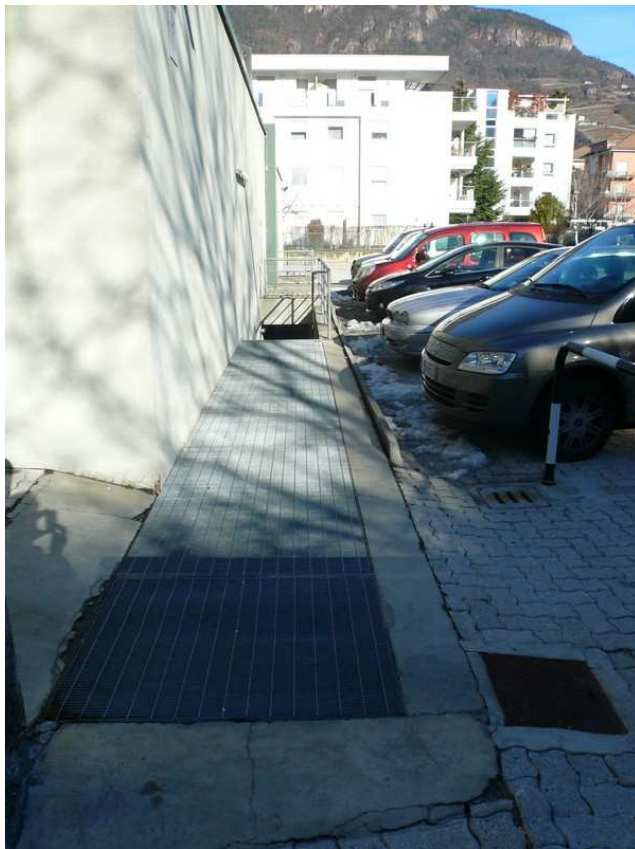
(Pavimentazioni sconnesse non complanari)
