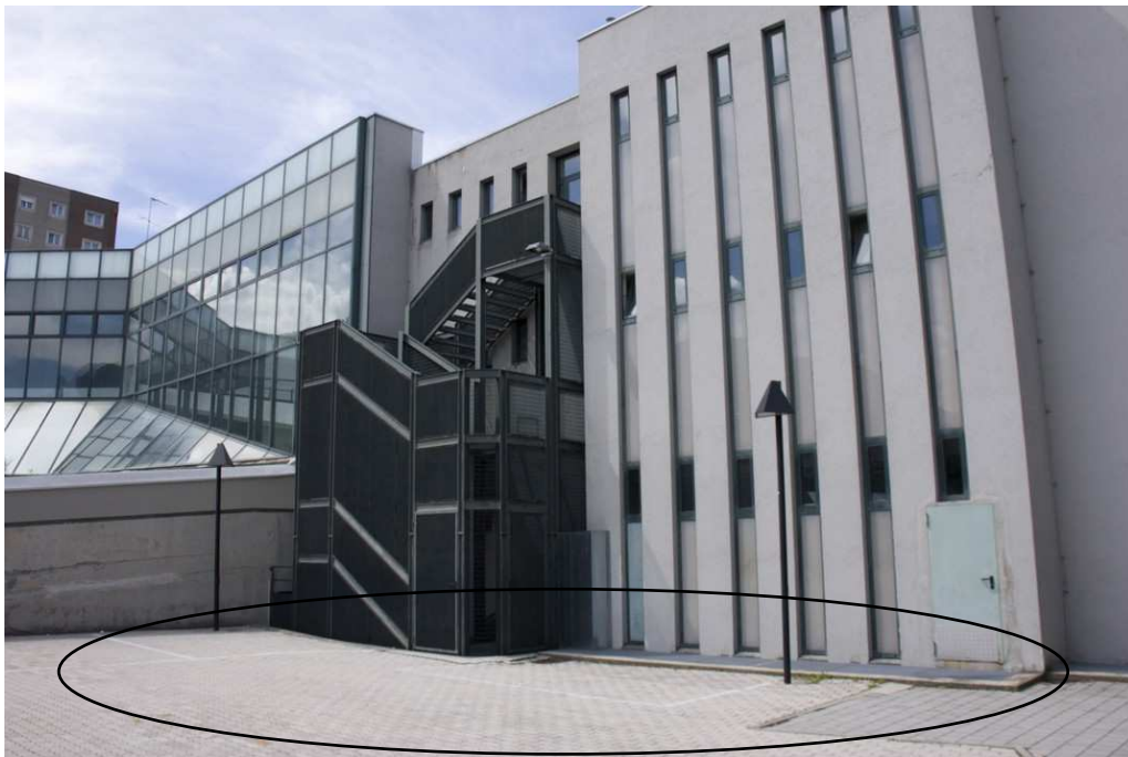
(Unebener Bodenbelag mit Setzungen)
