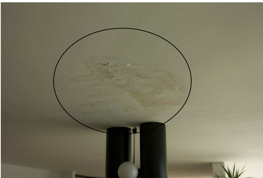
(Infiltrazioni al soffitto del secondo piano)
