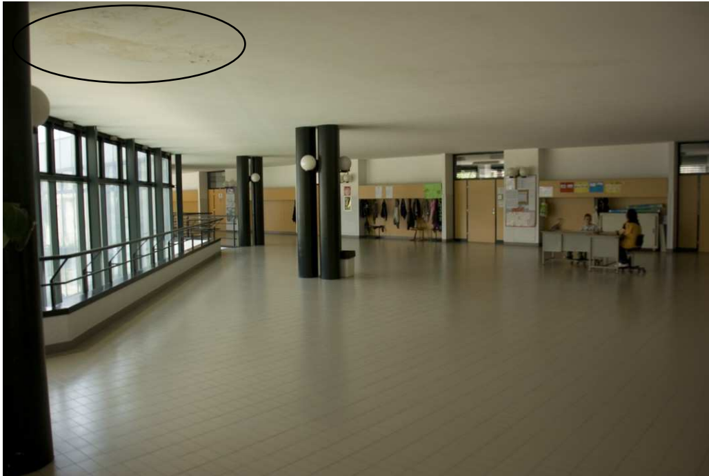
(Einsickerndes Wasser an der Decke des 2. OG)
