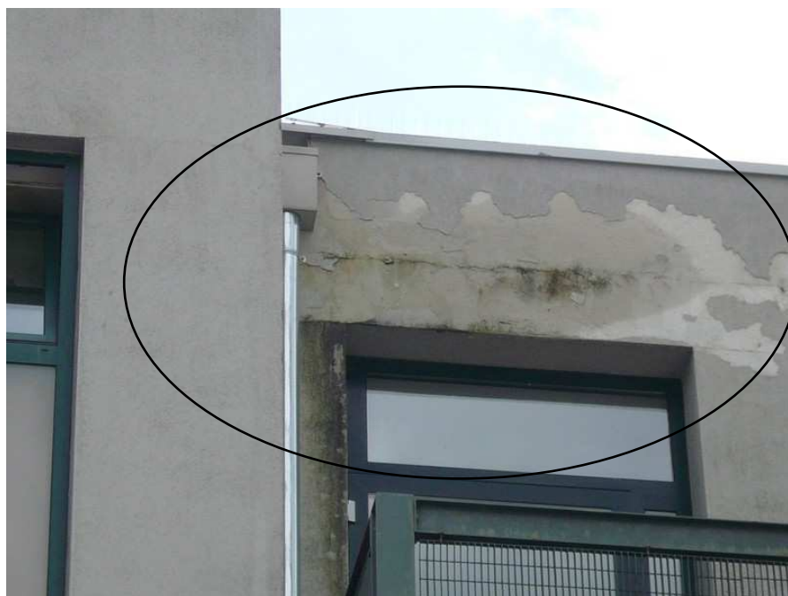
(Infiltrazioni in facciata con distacco intonaco)
