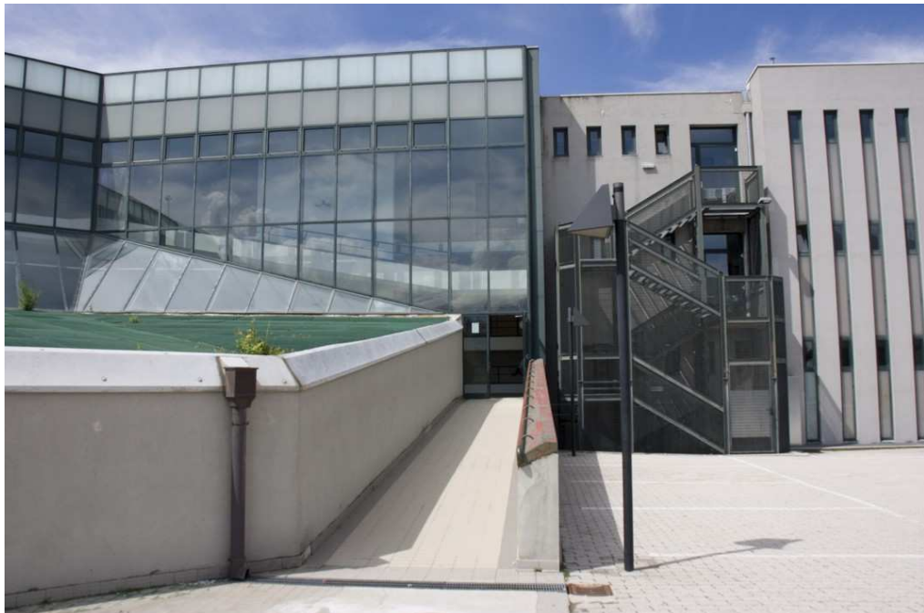
(rutschige externe Rampen, mit zu erneuerndem Bodenbelag)
