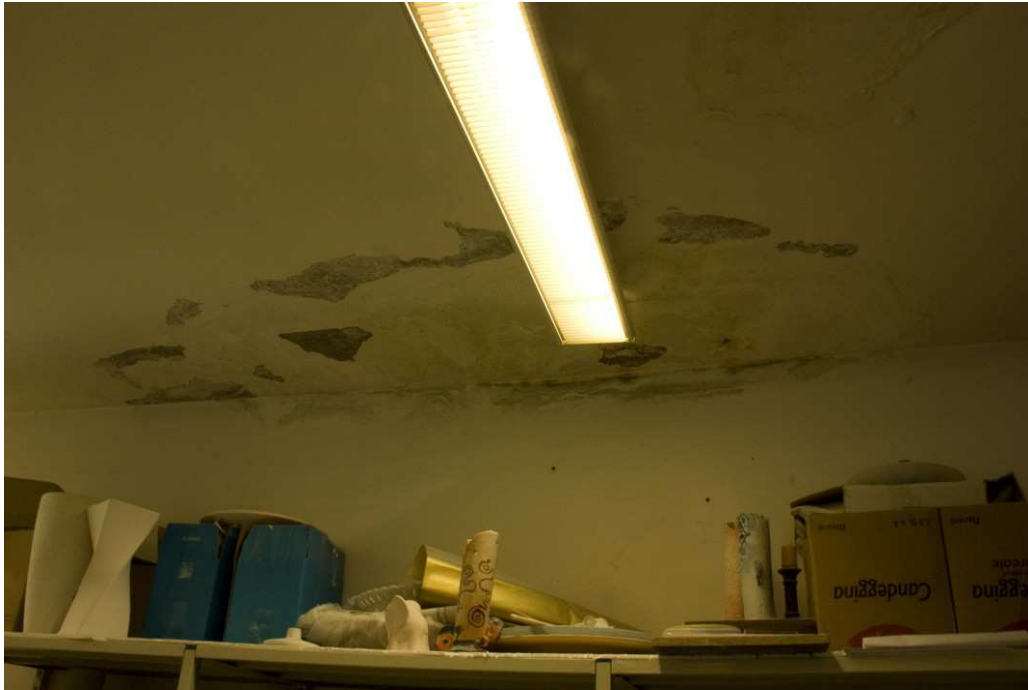
(Einsickerndes Wasser an der Decke des 2. OG)
