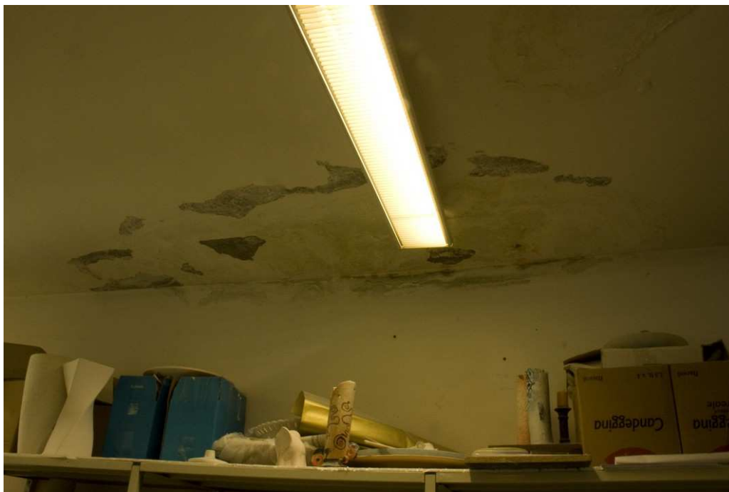
(Infiltrazioni al soffitto del secondo piano)
