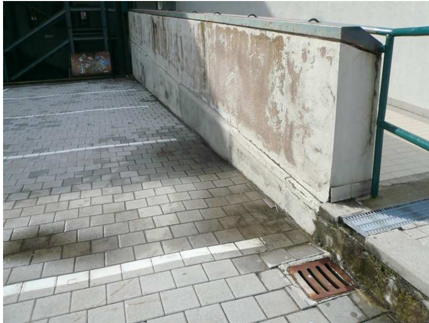
(Unebener Bodenbelag mit Setzungen)
