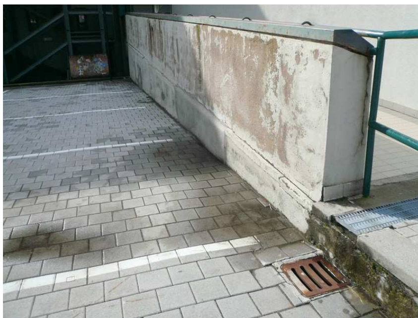
(Pavimentazioni sconnesse non complanari)
