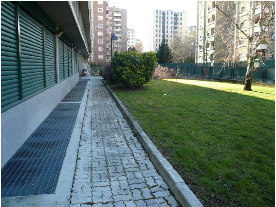
(Gehwege im Außenbereich mit Setzungen)
