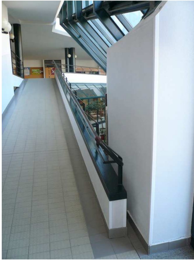
(rutschige interne Rampen, mit zu erneuerndem Bodenbelag)
