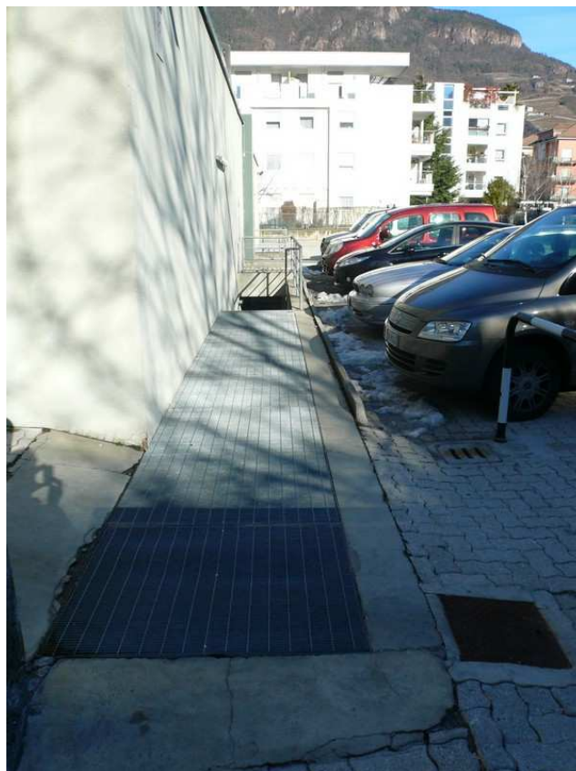
(Unebener Bodenbelag mit Setzungen)
