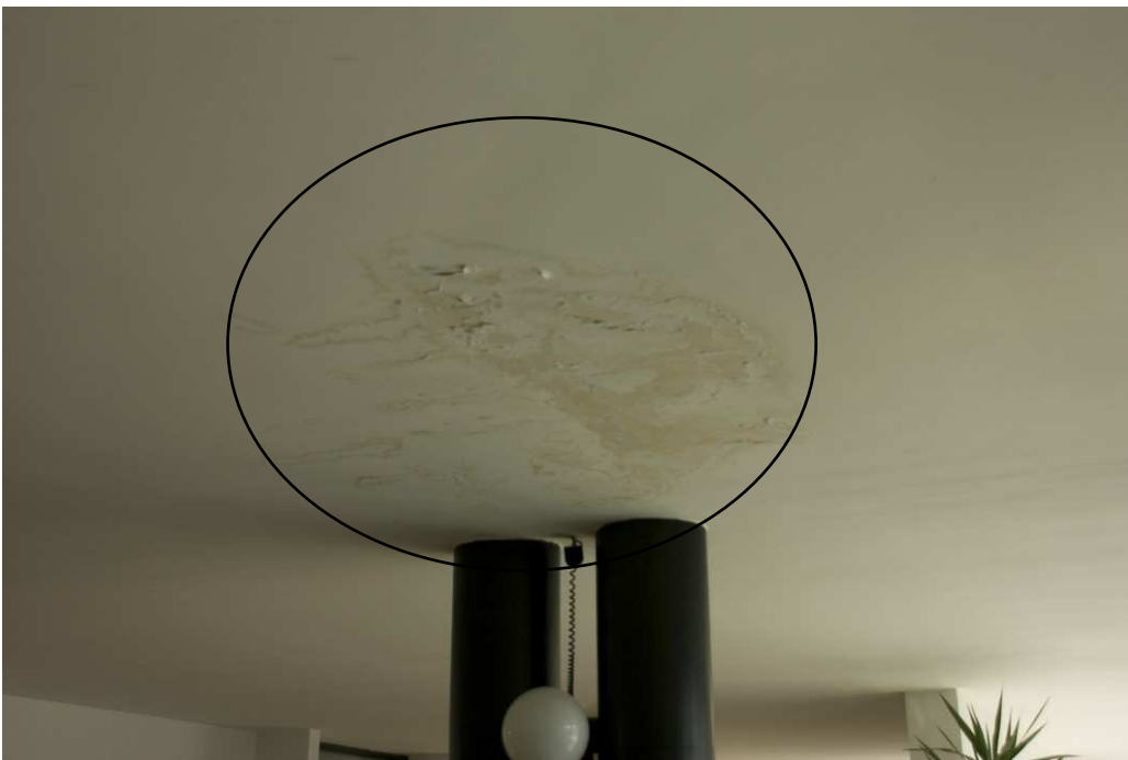
(Einsickerndes Wasser an der Decke des 2. OG)
