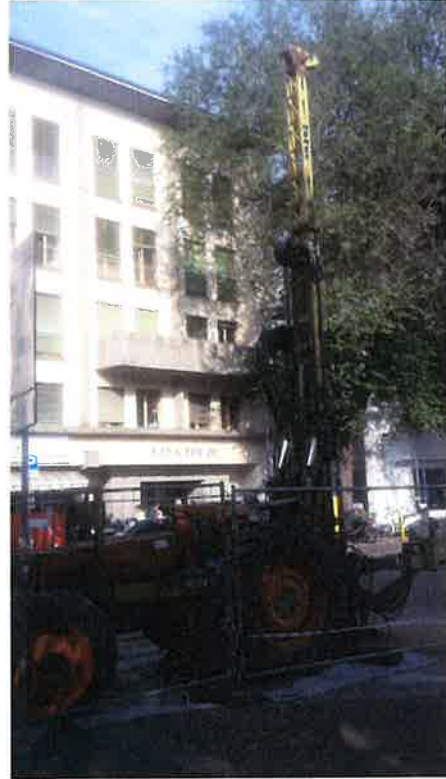
SONDAGGIO - BOHRUNG: S3/18
