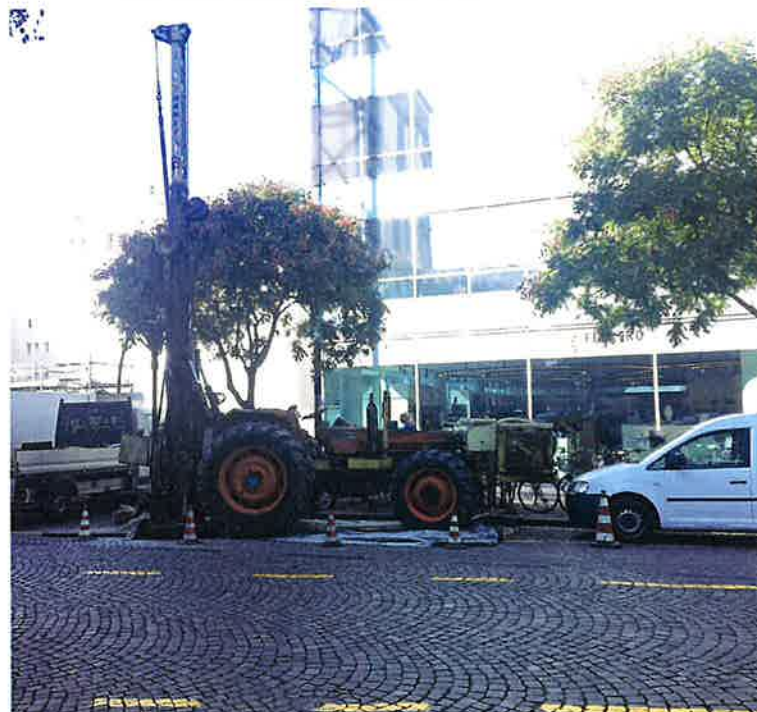
SONDAGGIO - BOHRUNG: S2/18
