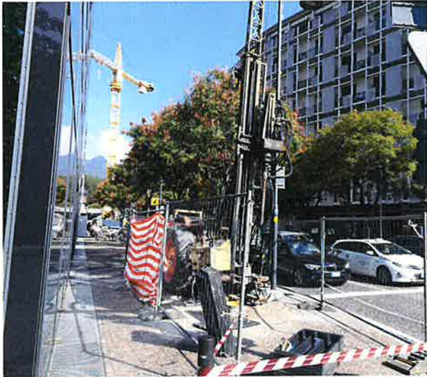
SONDAGGIO - BOHRUNG: S1/18
