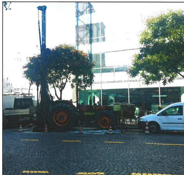
SONDAGGIO - BOHRUNG: S2/18
