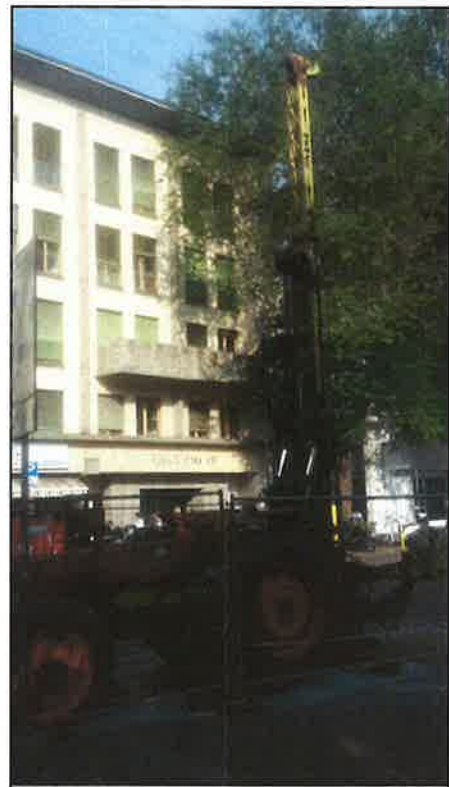
SONDAGGIO - BOHRUNG: S3/18
