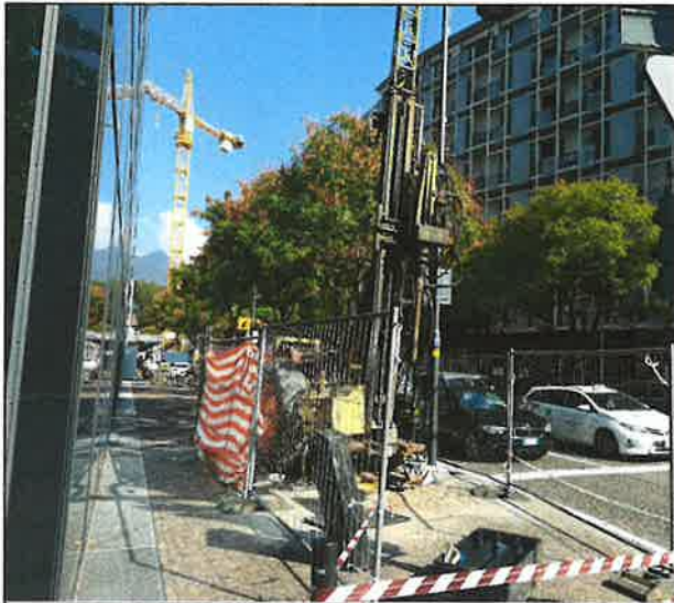
SONDAGGIO - BOHRUNG: S1/18
