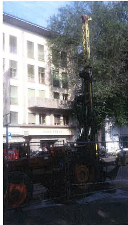
SONDAGGIO - BOHRUNG: S3/18
