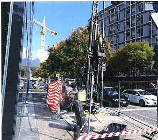
SONDAGGIO - BOHRUNG: S1/18
