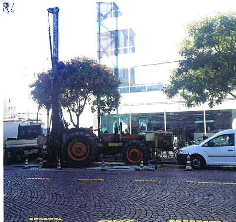
SONDAGGIO - BOHRUNG: S2/18
