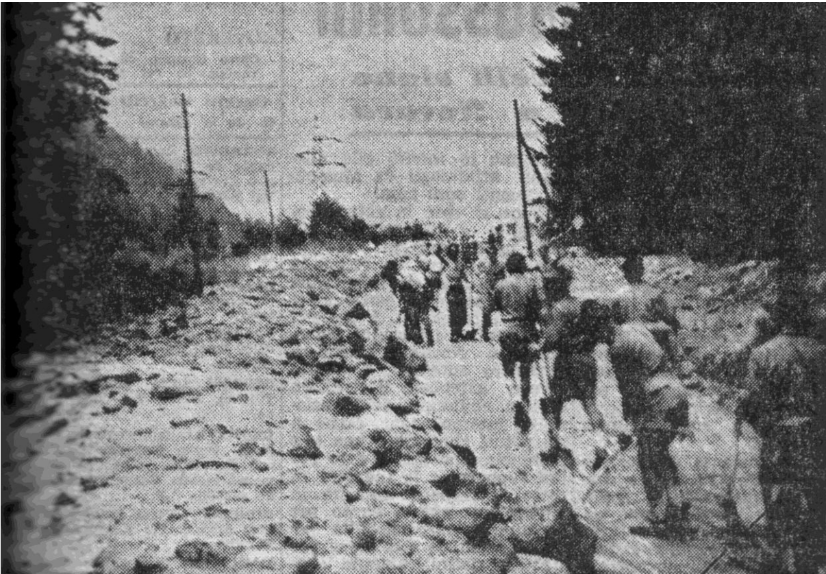
figura 8: Evento del 1957. Alpini al lavoro per sgomberare la strada del Brennero.
