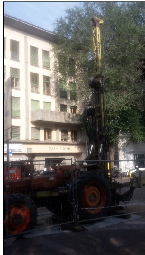
SONDAGGIO - BOHRUNG: S3/18
