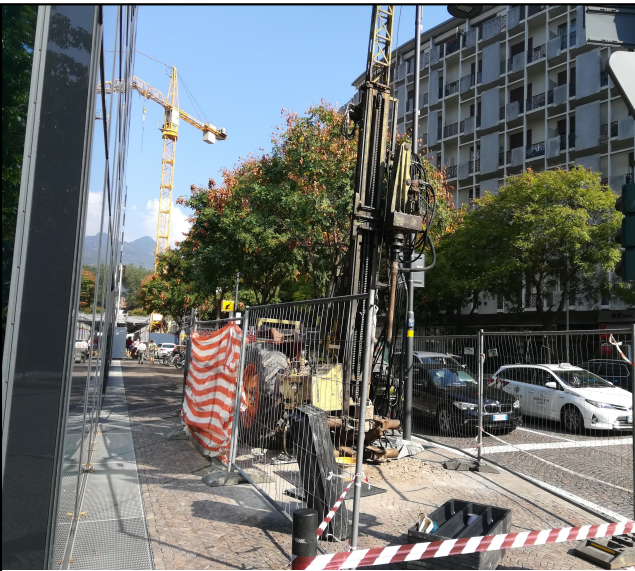
SONDAGGIO - BOHRUNG: S1/18
