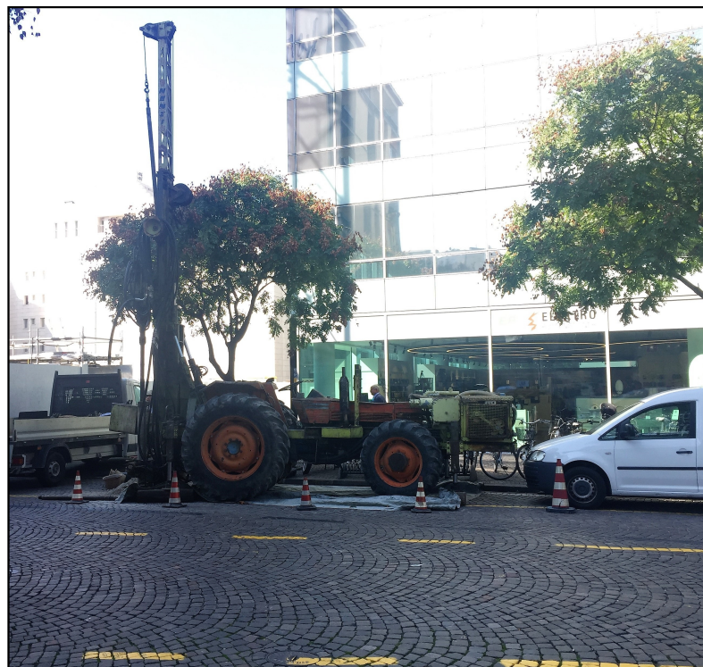
SONDAGGIO - BOHRUNG: S2/18
